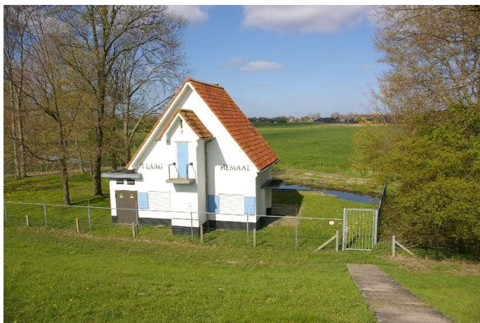
Figuur 17 Gemaal 't laag hemaal.
