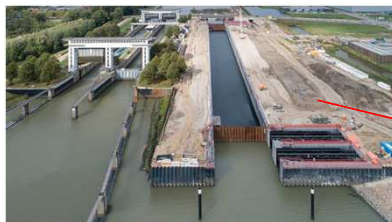
Aanleg 3 e sluisolk Beatrixsluis Nieuwegein Project Rijkswaterstaat
