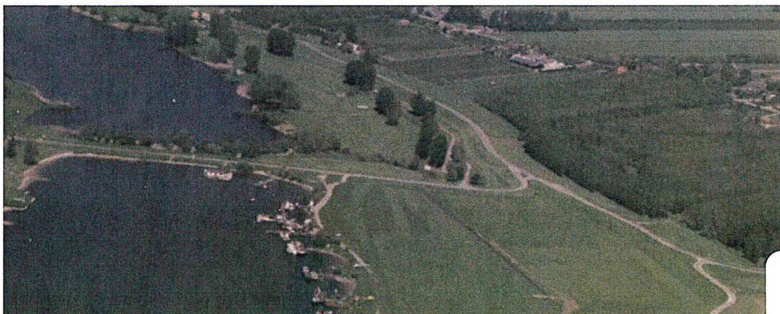
Luchtfoto 2002 met poldersloot welke aansluit op duiker
